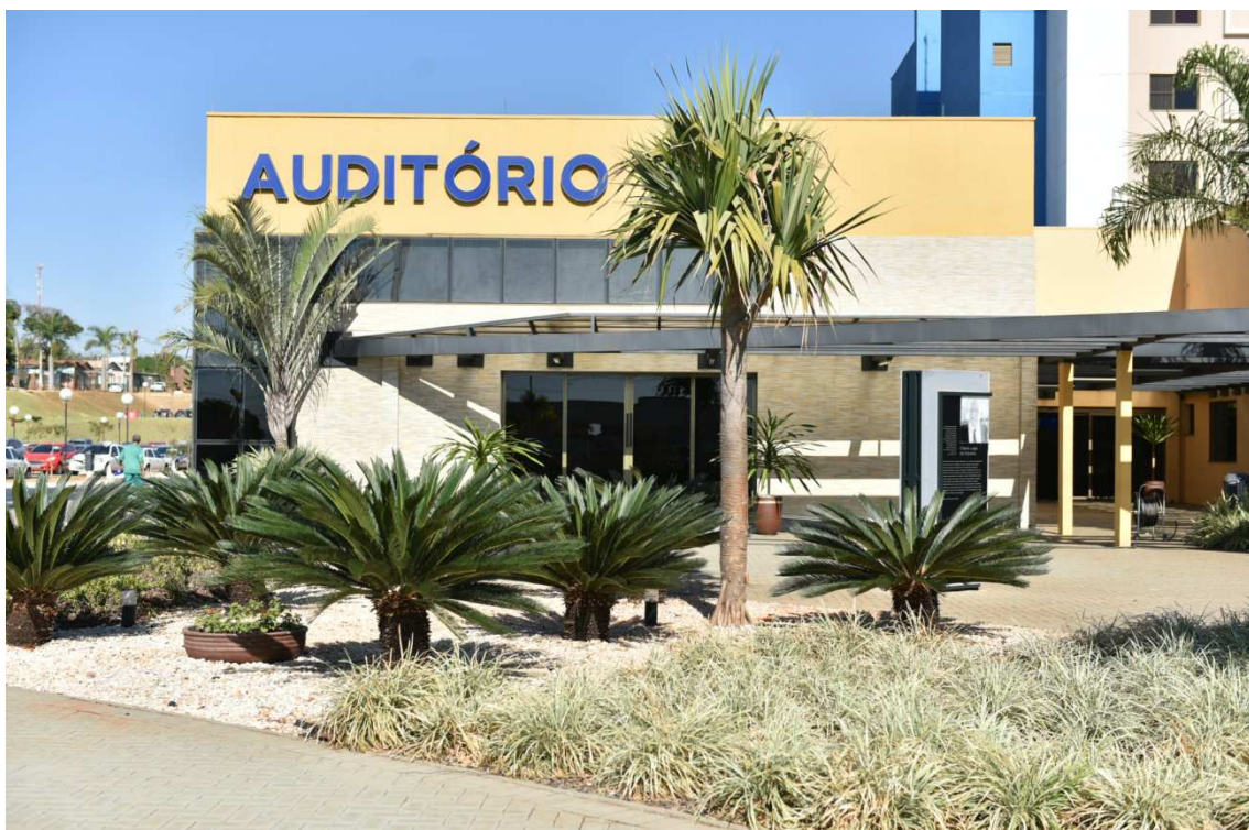
Foto 04 – Vista Geral do Auditório
