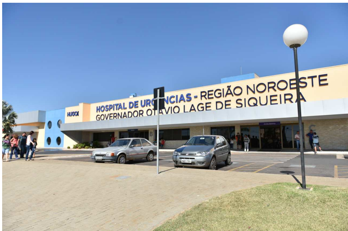
Foto 35 - Fachada do Hospital – Entrada do ambulatório
