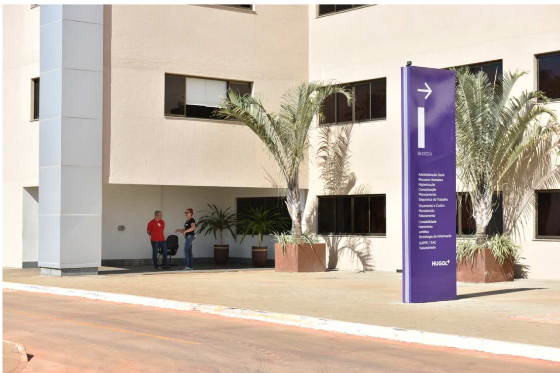
Foto 55 – Entrada e Saída do Bloco I- Prédio Administrativo
