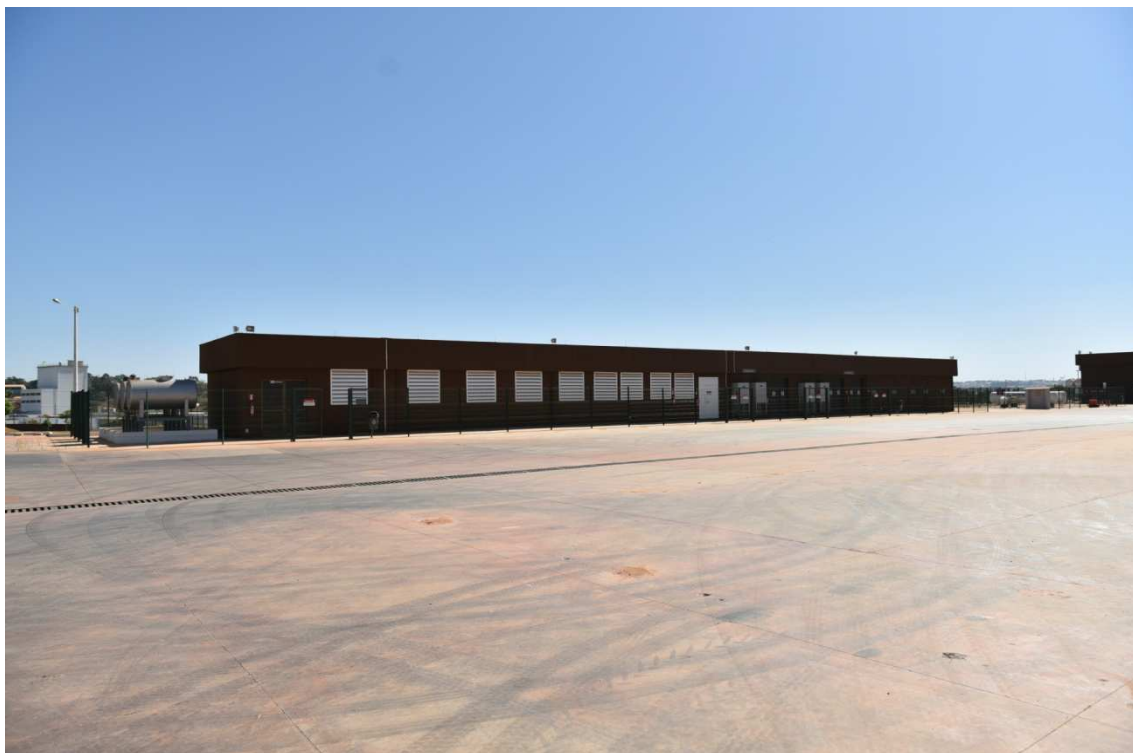
Foto 59 – Subestação de Energia
