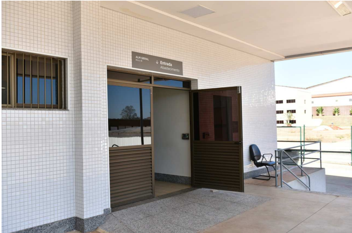
Foto 49 – Entrada do Almoxarifado Geral
