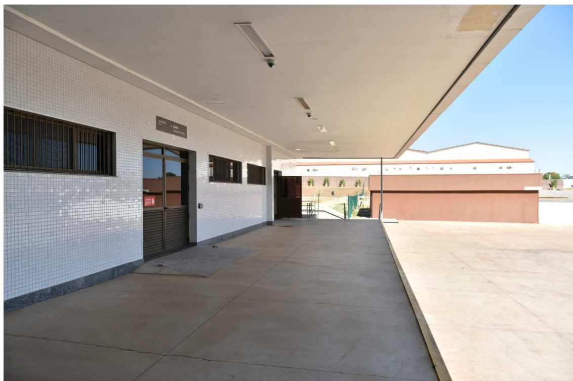
Foto 48 – Ala de Acesso ao Almoxarifado Geral
