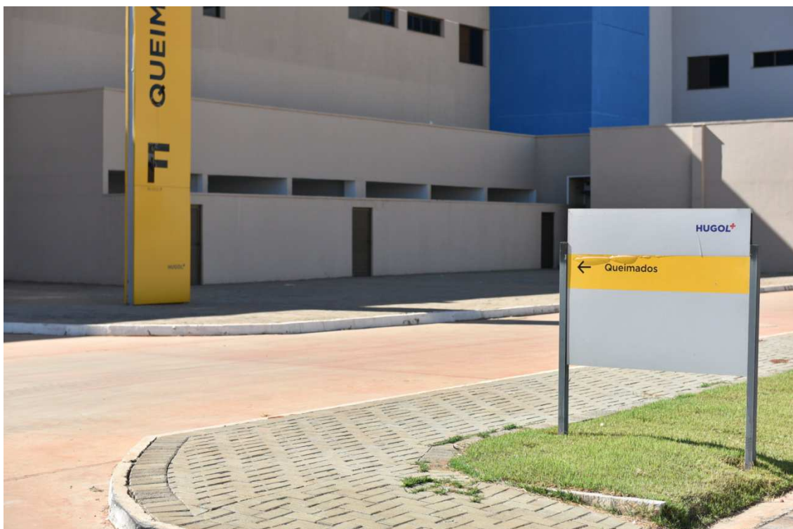
Foto 53 — Bloco F – Acesso a Ala de Queimados
