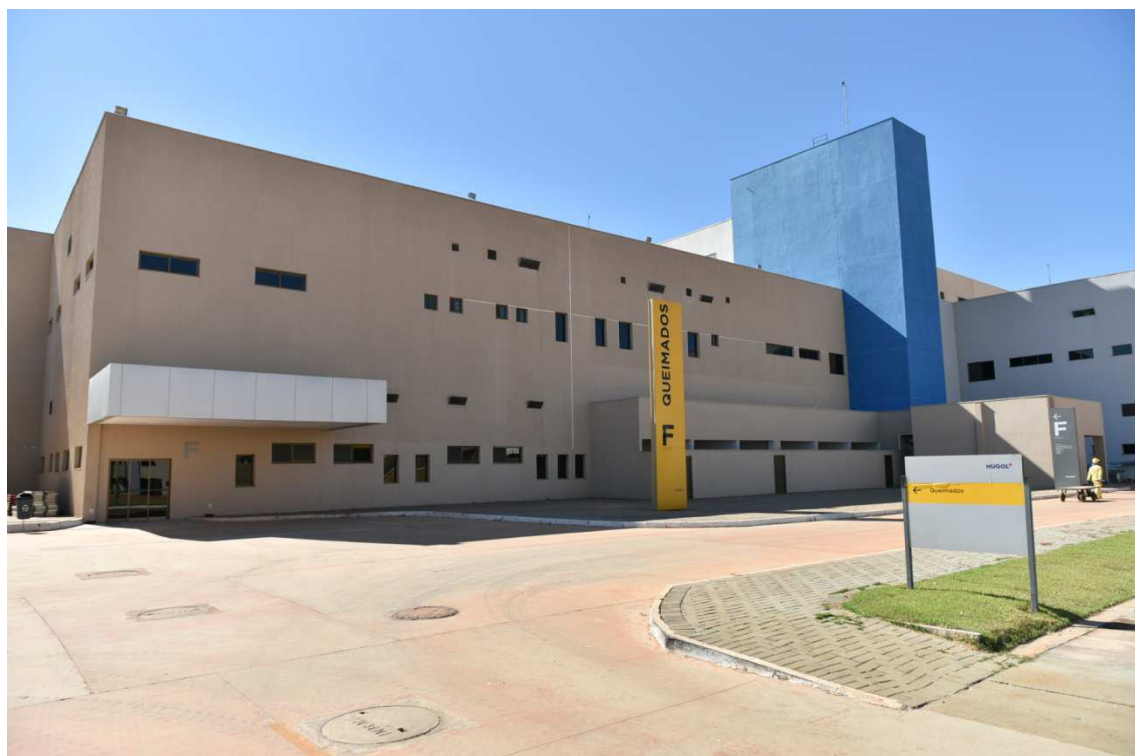
Foto 52 – Bloco F – Acesso externo para a Ala de Queimados
