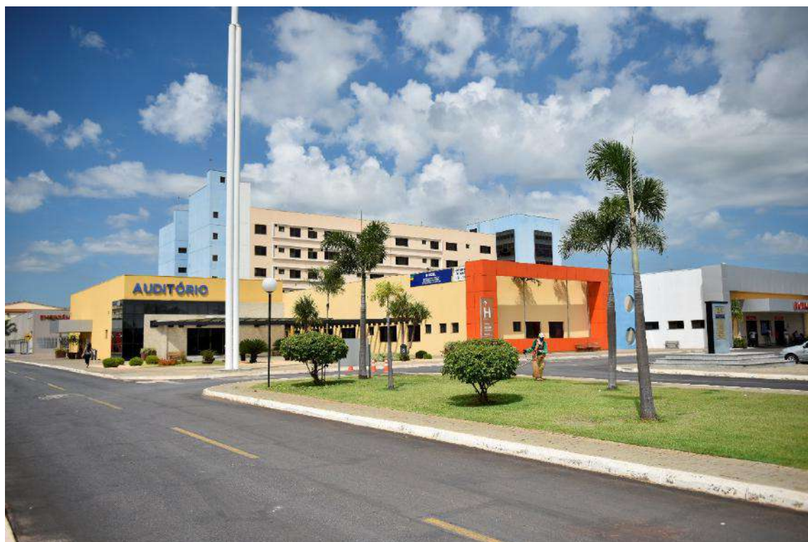
Foto 03 – Vista Geral do Auditório e parte do HUGOL
