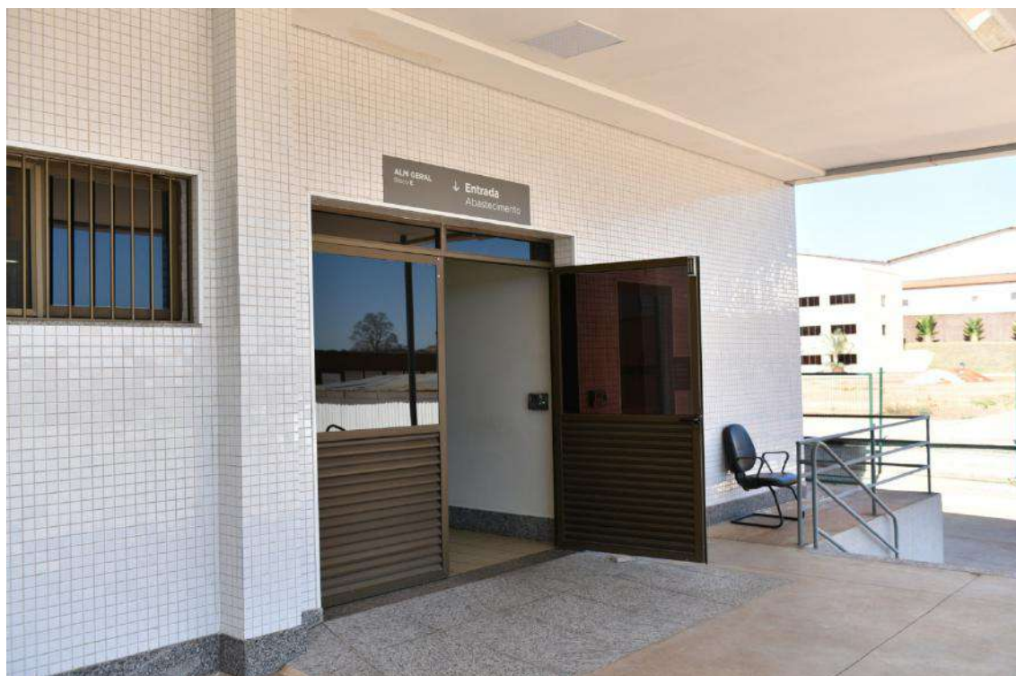
Foto 49 – Entrada do Almoxarifado Geral
