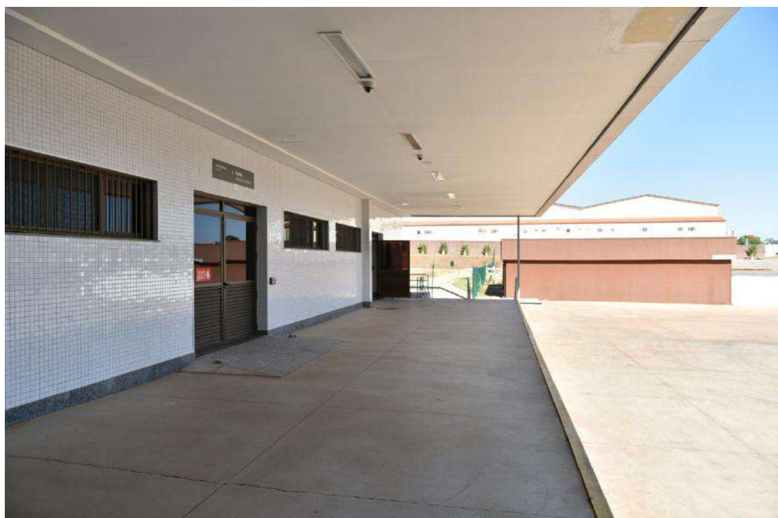
Foto 48 – Ala de Acesso ao Almoxarifado Geral
