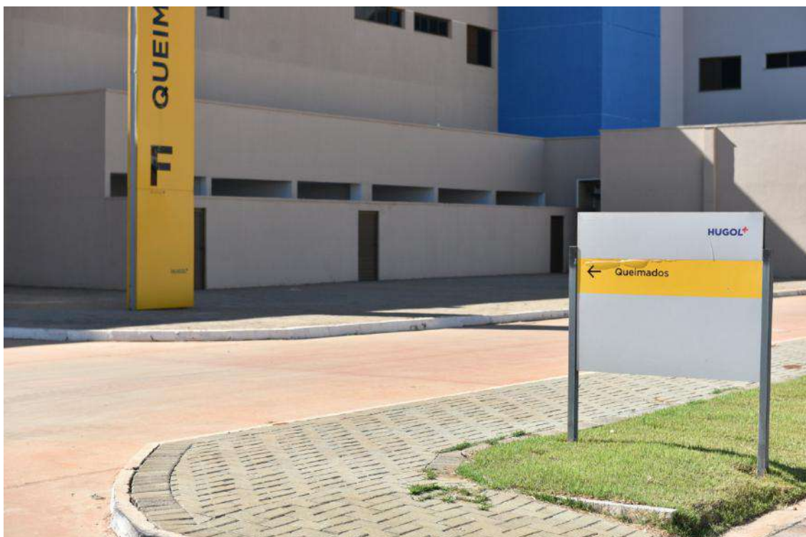
Foto 53 – Bloco F – Acesso a Ala de Queimados
