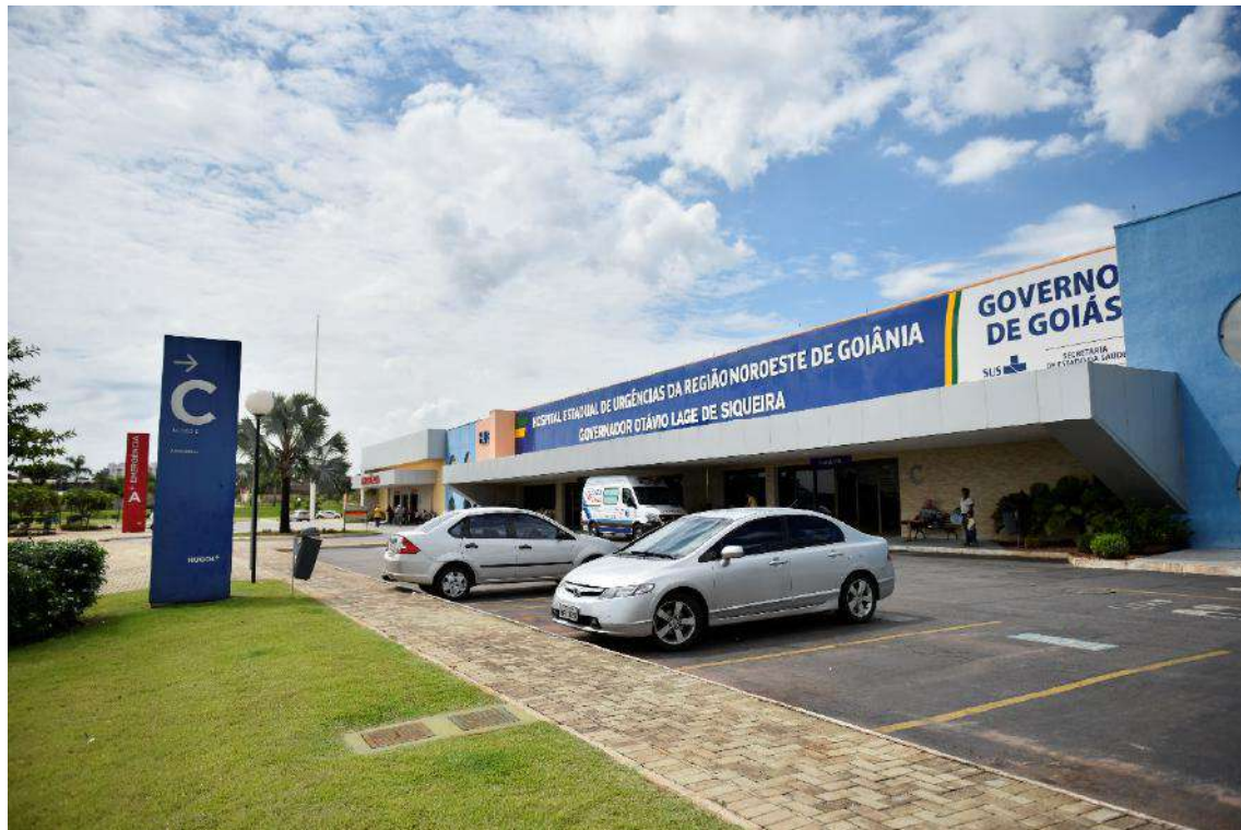
Foto 35 – Fachada do Hospital – Entrada do ambulatório
