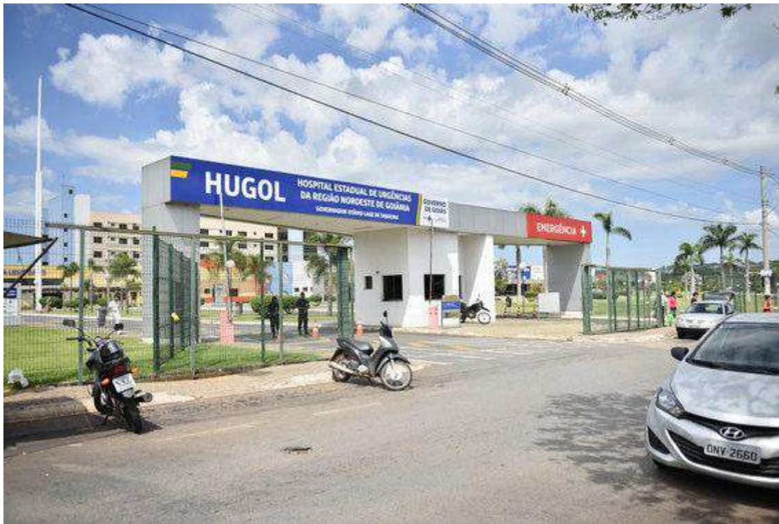
Foto 01 – Guaritas das entradas principal e de Emergência
