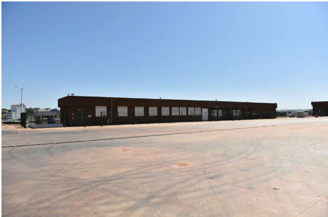
Foto 59 – Subestação de Energia
