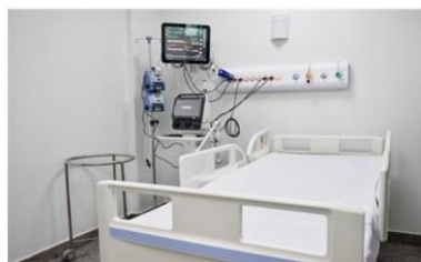
Figura 4- Leito da unidade crítica
